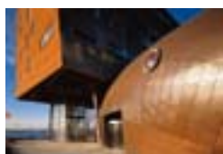
Городской Центр Развлечений, Альмере, NL Will Alsop Architects, Лондон Ridder Dak- en Wandsystemen BV, Хорн TECU® Латунь
